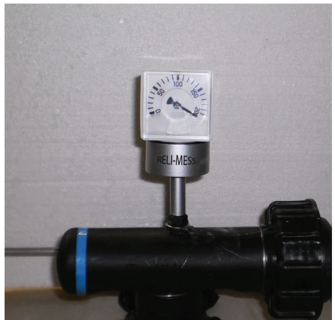
Einbau im Bereich Verbindung Luftleitung Passt Immer
